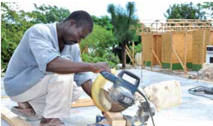
Im haitianischen Port-au-Prince wird nach dem Erdbeben eine neue Krankenpflegeschule errichtet. Einheimische werden dabei gern beschäftigt.
