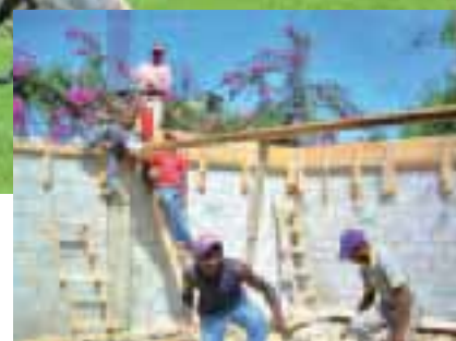
Wiederaufbau der Volksschule in Haiti.
