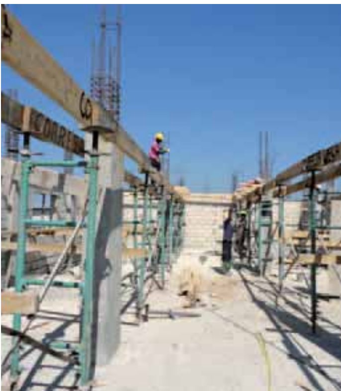
Der Speisesaal im Bau.
