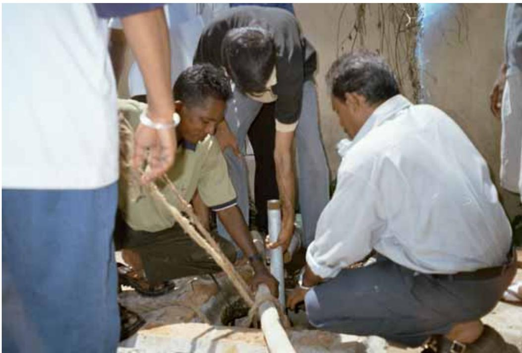
Einbringen der Tauchpumpe in den Brunnen für frisches Wasser.
