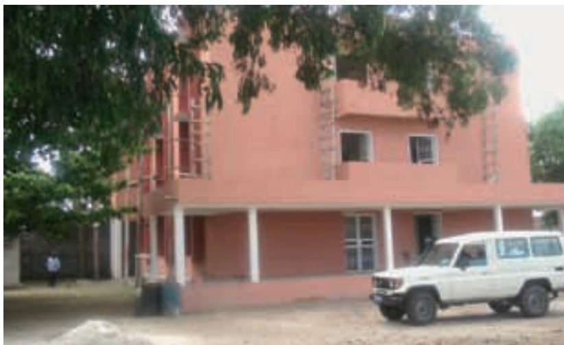
Jean-Claude Derivaux begleitet den Bau der Augenklinik in Masina, einem Stadtteil von Kinshasa, in dem rund zwei Millionen Menschen leben.
