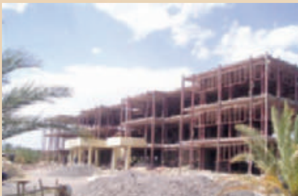
Die gesamte Verkleidung wurde wieder entfernt, um die Grundkonstruktion erdbebensicher zu verstärken.
