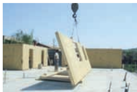
... und anschließender Aufbau vor Ort.
