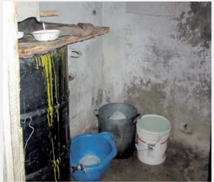
Das Badezimmer des Hauses ...
