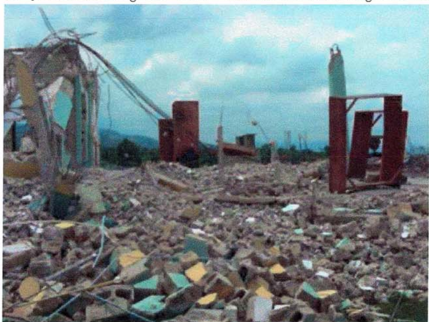
Das zerstörte Internat
