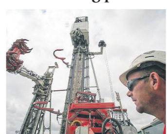
Die Geothermie-Bohrung in Poing 2008. FOTO: DZIEBALLA
