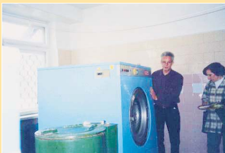
Das Fenster musste herausgenommen werden, um die Waschmaschine mit einem Kran in die Waschküche zu bekommen.
