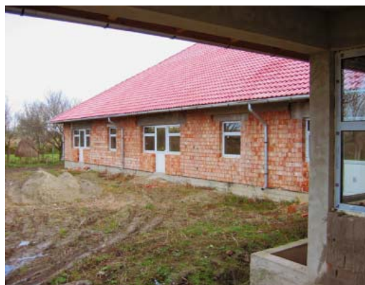
So weit – so gut: Zum ersten Mal sahen wir den Rohbau.
