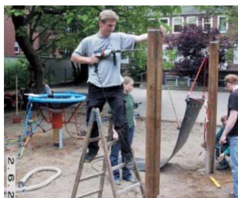
Für den Bau des Klettergerüsts mussten die Krefelder Leos schweres Geschütz auffahren.
