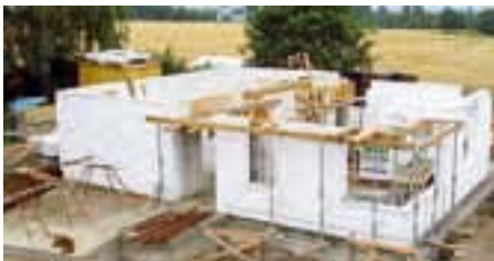
Der Rohbau steht. Hier entstehen die neuen Wohnblocks des Friedensdorfes.
