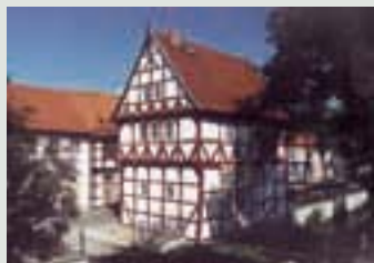
Fachwerkhaus in Salzwedel
