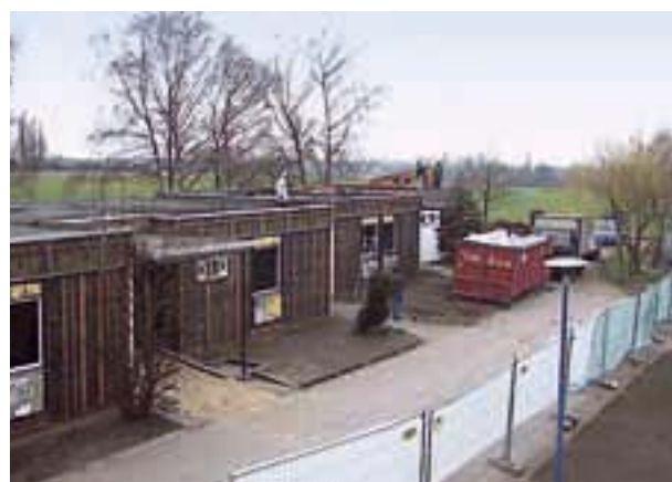
Der alte Wohnbereich kurz vor dem Abriss.
