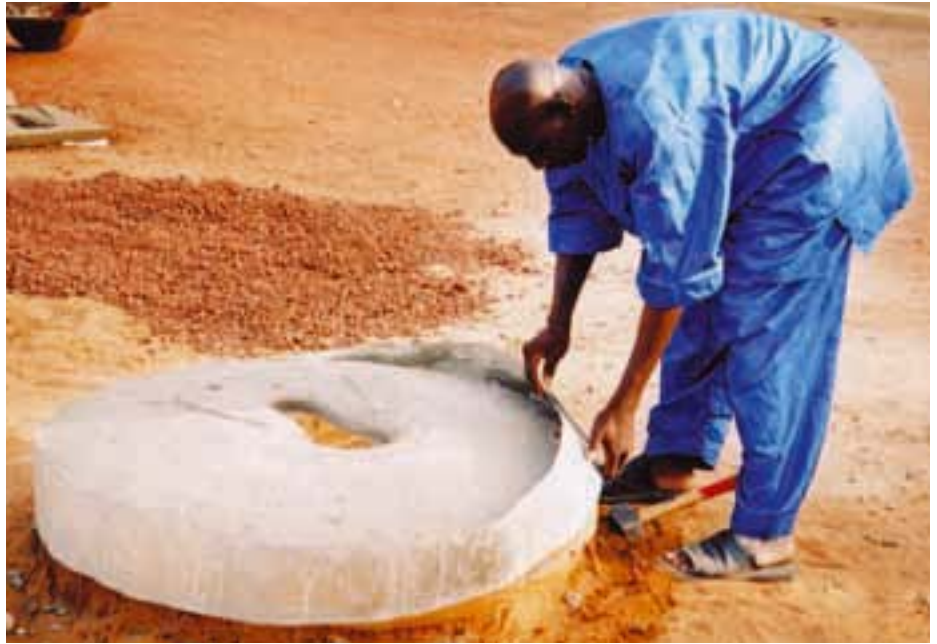
Latrinenbau in Mali, denn saubere Sanitäranlagen verhindern Trachom.
