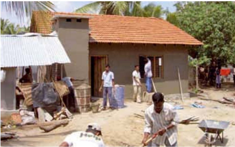
Die Bewohner beteiligten sich engagiert an Wiederaufbau und Reparatur ihrer Häuser.
