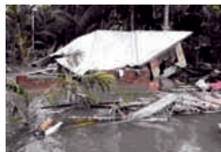
Der Tsunami richtete große Schäden an, deren Behebung bis heute andauert.
