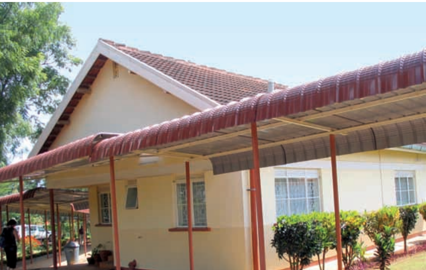
Überdachte Wege zwischen den Gebäuden schützen Personal und Patienten vor stechender Sonne und Regengüssen.
