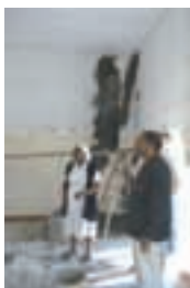
Die Reparaturen beginnen.
