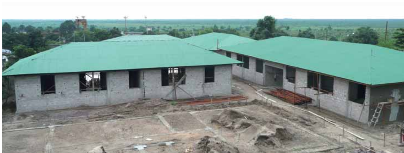
Alle Rohbauten der Lions-Augenklinik stehen. Im März 2009 beginnt der Klinikbetrieb im Übergangsgebäude.
