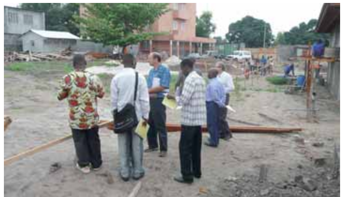
Lions und CBM-Mitarbeiter überzeugen sich vom aktuellen Stand der Baumaßnahmen in Kinshasa.
