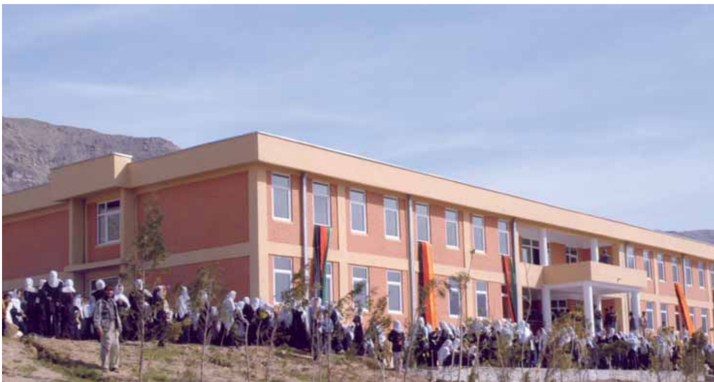
Anfang November wurden die beiden neuen Gebäude eingeweiht. Sie beinhalten eine Mutter-Kind-Ambulanz sowie einen Kindergarten.
