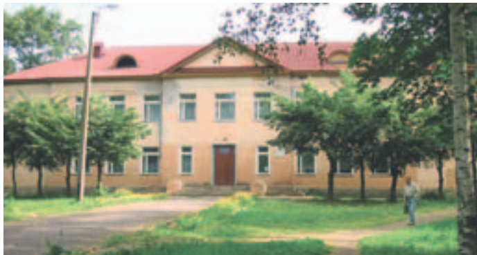
Die Schule in Rachja nach der Renovierung durch die Lions.
