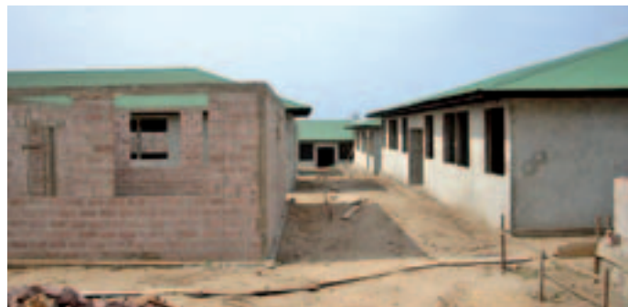
In diesen Gebäuden entstehen die Behandlungs- und OP-Räume.
