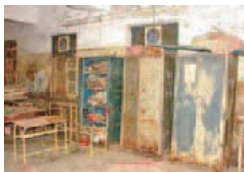
Die beschädigten Unterrichtsräume erhalten neues Mobiliar.
