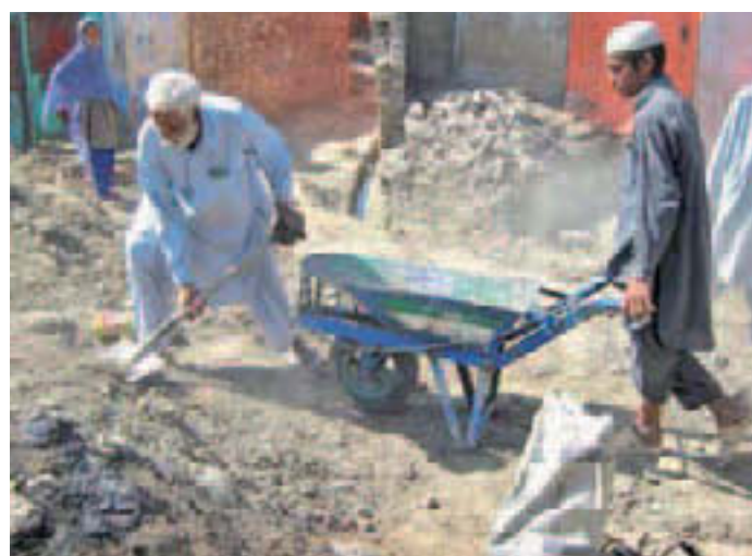
Arbeiter räumen Schutt von den Schulhöfen.
