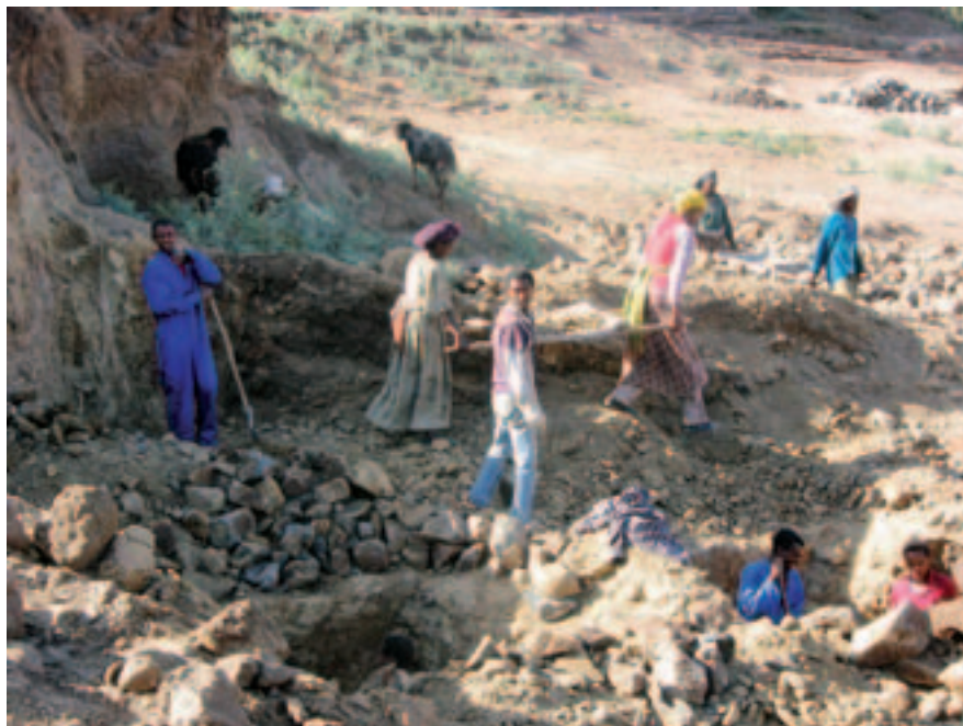
Links groß im Bild der Stand der Fertigstellung im Juni 2011, rechts der beschwerliche Anfang im November 2009: Steine über Steine.
