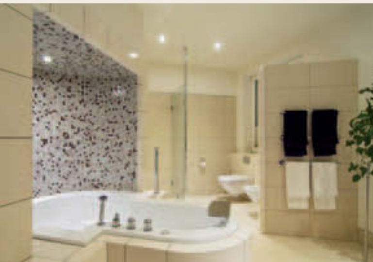
Bild: Hilpert – Von Hand gefertigte Keramik folgt der Rundung der Körperformwanne und verkleidet auch die Stirnseiten der Wandnische.
