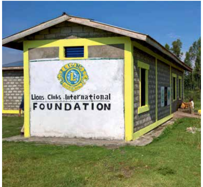
Das fertige Waschhaus , in dem das durch Solarbrunnen und Hochtank bereitgestellte Wasser in einen ausgeklügelten Nutzungskreislauf gebracht wird.
