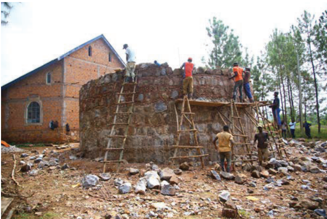
Bau einer Zisterne
